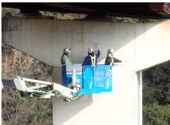
橋梁点検の様子
