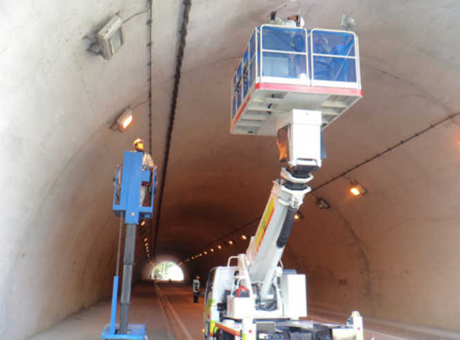
トンネル点検・補修業務の様子
